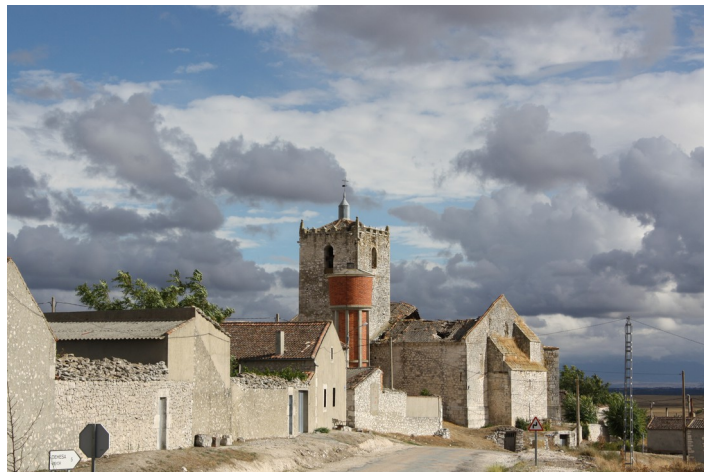
Iglesia de este mismo pueblecito: ya no se usa desde 1988; veis que el tejado se ha hundido. Con el Evangelio en la mano, ¿qué impide que una mujer casada sea ordenada para servir a su comunidad?
